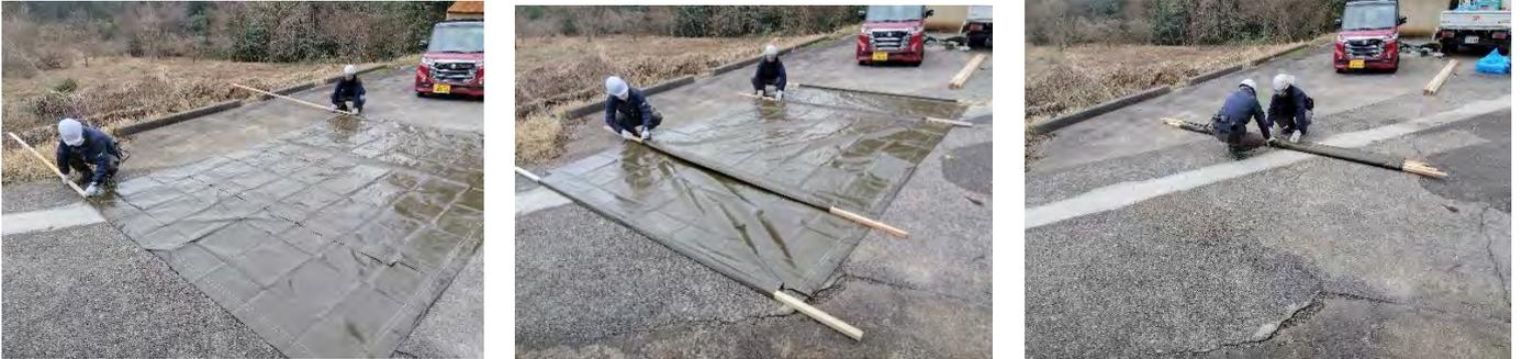
② まとめたシートを屋根に乗せ、棟から手を放すだけで落ちていきます。袋に入っている「よこ栈」「たて栈」をビス止めするだけで固定され、屋根上の足場となり作業者の体を支えてくれます。
