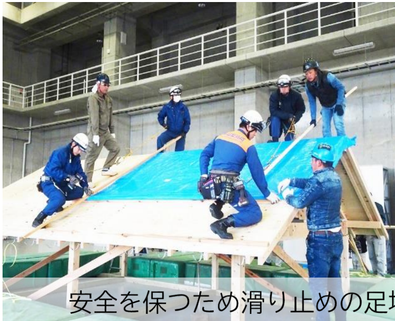
災害用シートに木材を巻き込み、風に耐えられるよう加工
