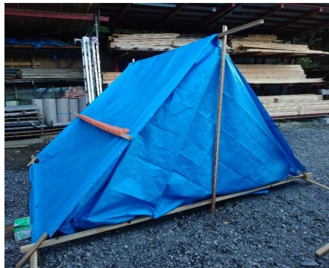
④目隠しのシート止め完成
